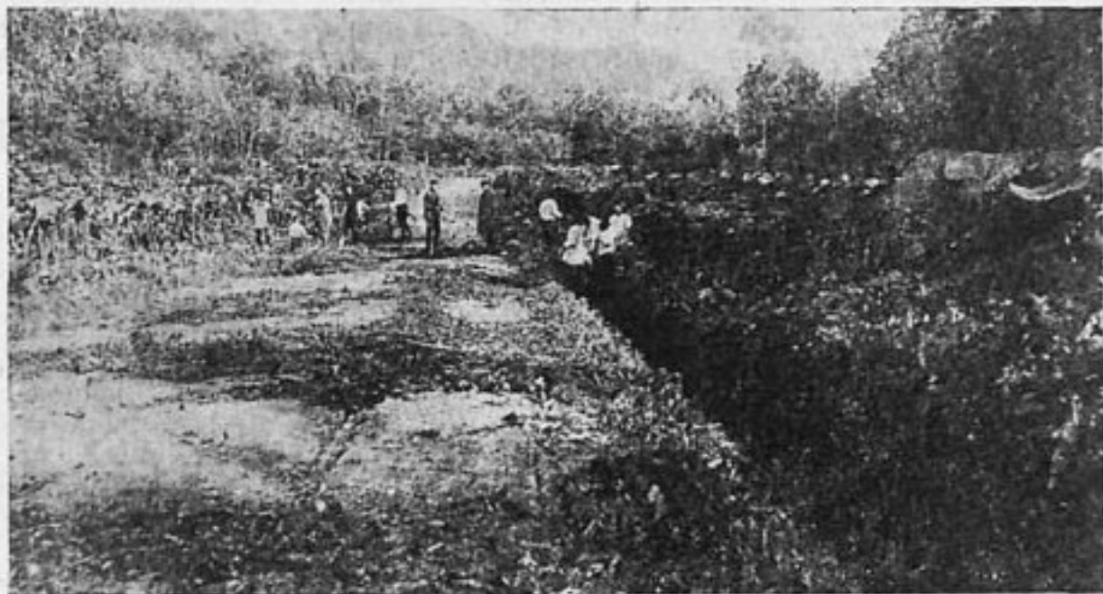
Ремонт дороги к селу Дербинск на Сахалине
